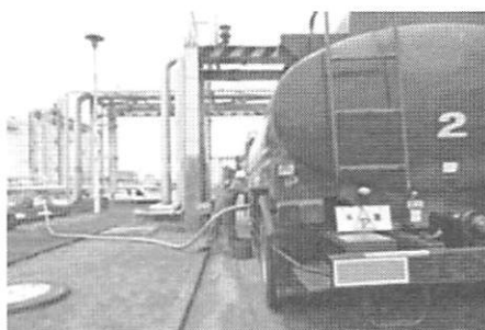
簡易保全工事(油回収)
