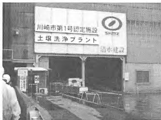
(常設型 土壤洗浄プラントの概観)
