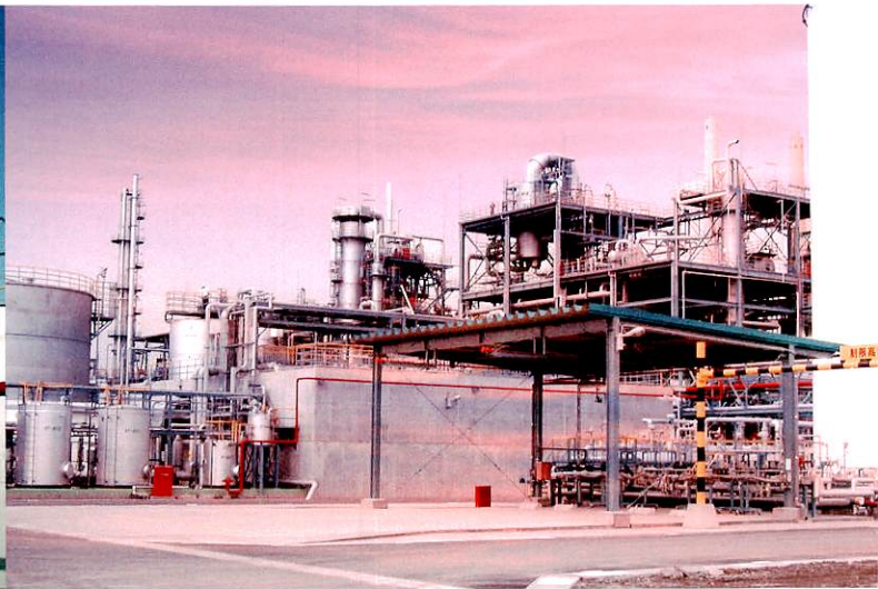
アニリン製造設備
